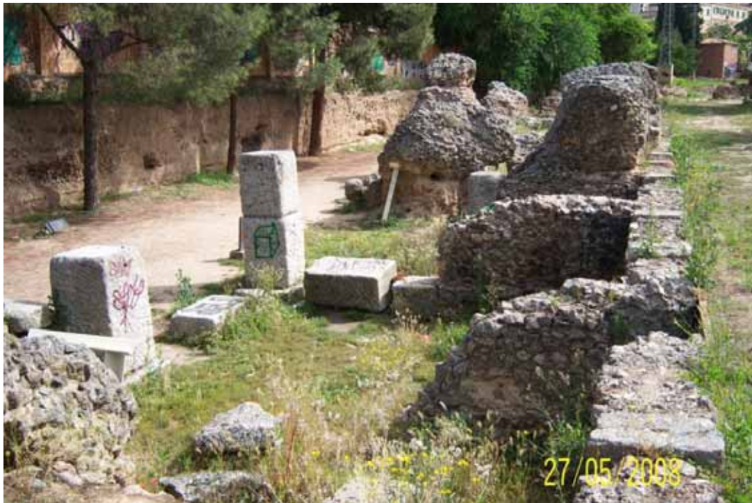
Foto nº 4: Restos de graderíos dañados por pintadas
